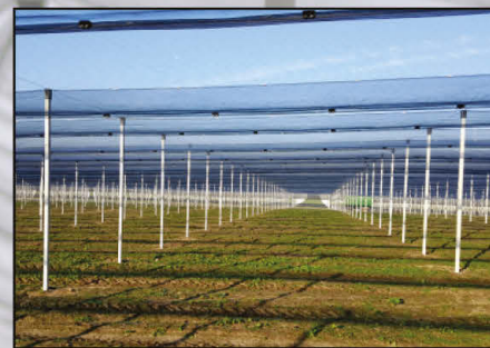
Konstrukcije na betonskim i drvenim stubovima
